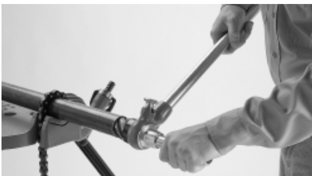
Рис. 2 – Зенкование края трубы.
