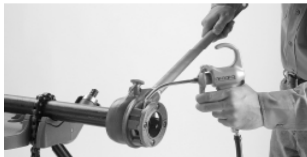
Рис. 4 – Нанесение резьбонарезного масла на трубу
