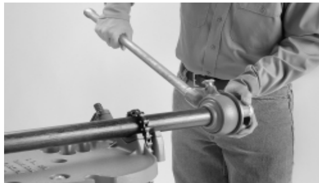
Рис. 3 –Установка инструмента на трубе.
