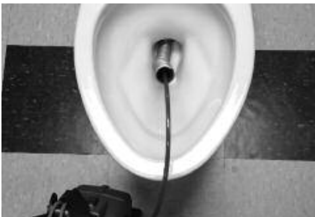
Рис. 25. Использование гибкой направляющей трубы
