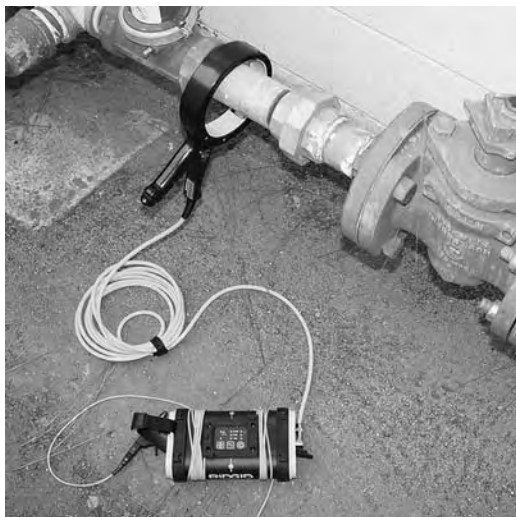
Рис. 9: Индукционный зажим присоединен к проводнику
